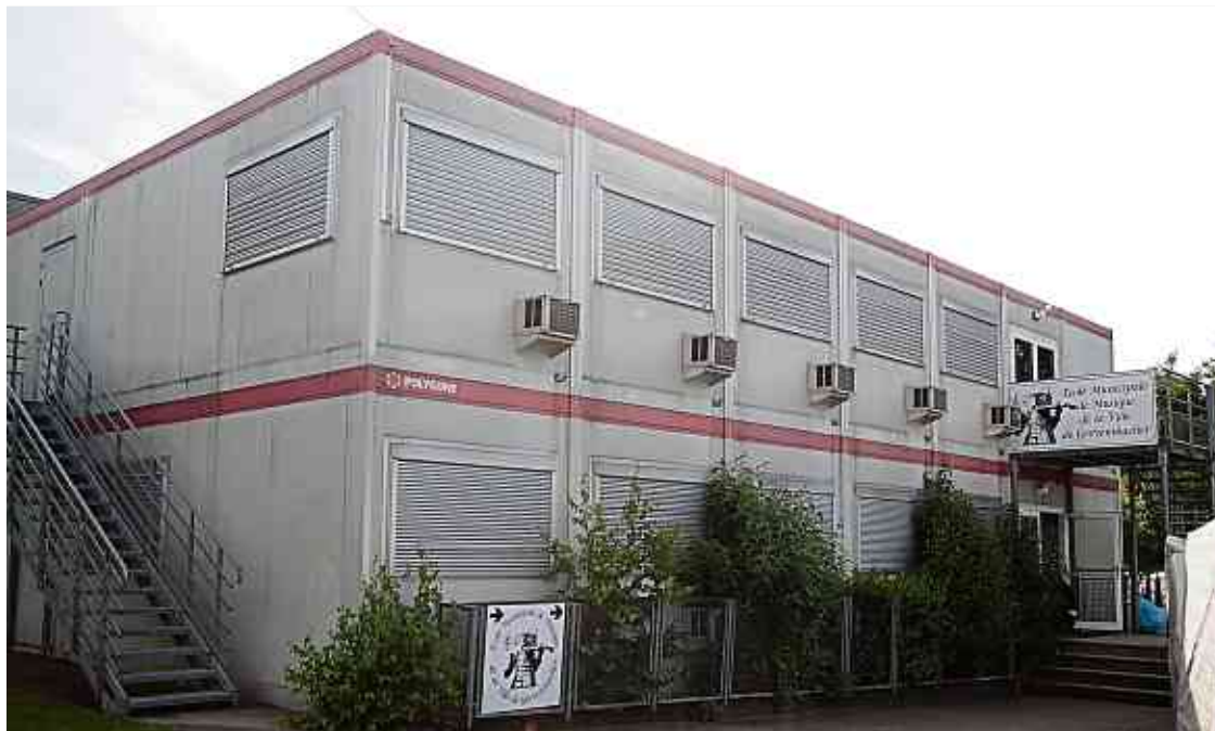
Eine provisorische Unterkunft: Nachdem die Decke in der Musikschule im August 2015 eingestürzt war, werden die Kurse derzeit in den ehemaligen Containern des „Maacher Lycée“ gehalten. (FOTO: NADINE SCHARTZ)
